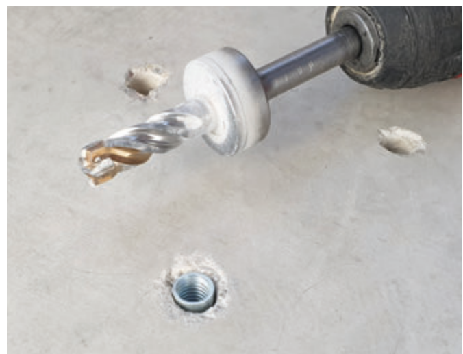
Zum Setzen von Einschlagankern
